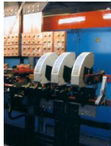
Contacteur de type CBA 98 4 500 A.2.0 ; Tension de service = 3 500 Vac ; I th = 4 500 A ; Pouvoir de coupure de 25 kA avec \cos \varphi = 0,1
